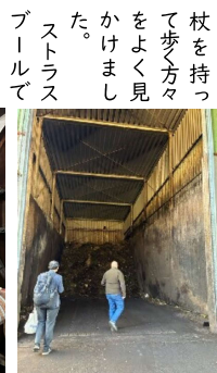
バイオマス発電所
