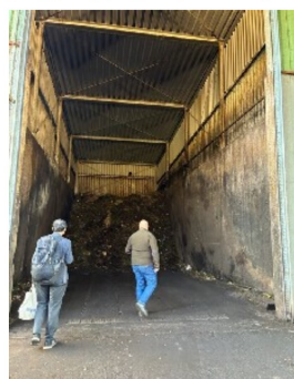
バイオマス発電所
