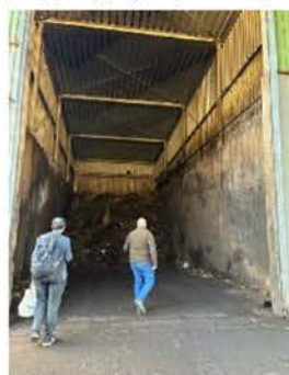
バイオマス発電所
