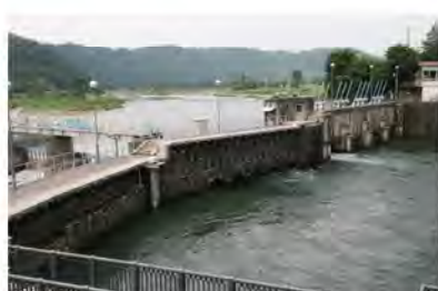
(上) 現代の羽村取水口。水門の向こうが多摩川本流、手前が玉川上水。筆者撮影。第一水門から水を取り入れ水量も多い。
