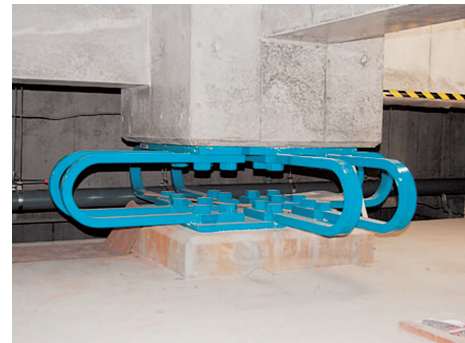
地震エネルギーを熱エネルギーに変換する制震支承
